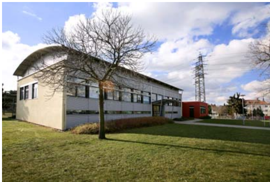
Abbildung 2 Querverbundleitstelle des VNB mit integrierter Smart Grid Leitstelle
